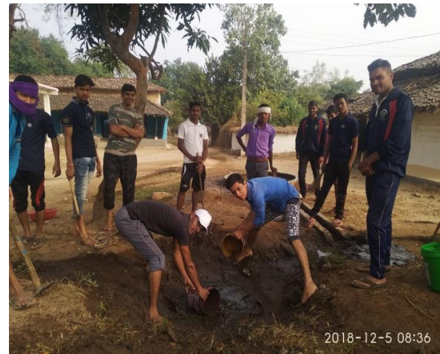
सोखता गढ़ा का निर्माण
