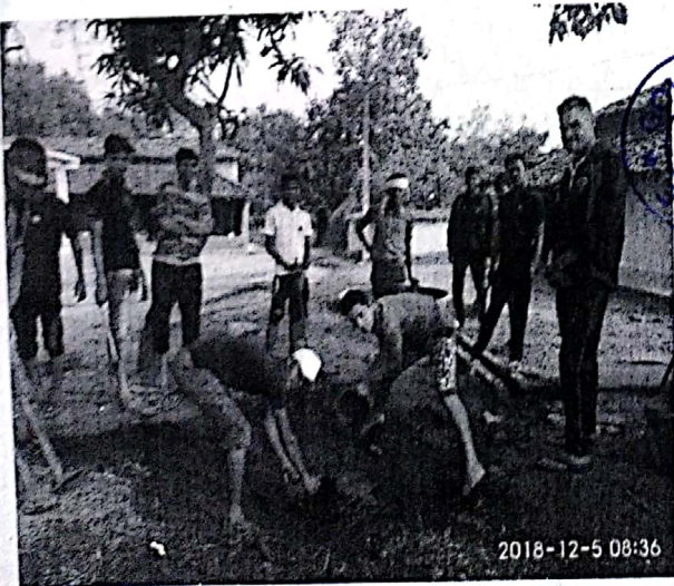
सोखता गड्ढा का निर्माण
